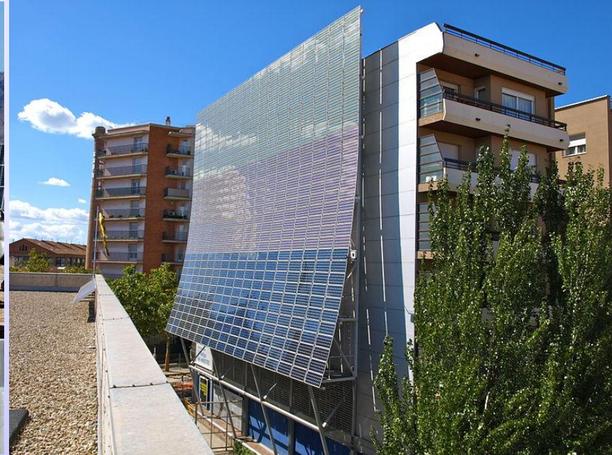
Fachada de edifício na Espanha
