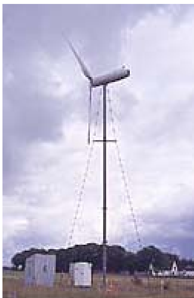
Figura 3.17. Aerogerador com rotor a sotavento ( downwind ).
