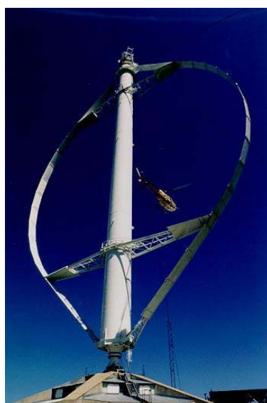
Figura 3.12. Aerogerador Eole C. 4,2 MW.
