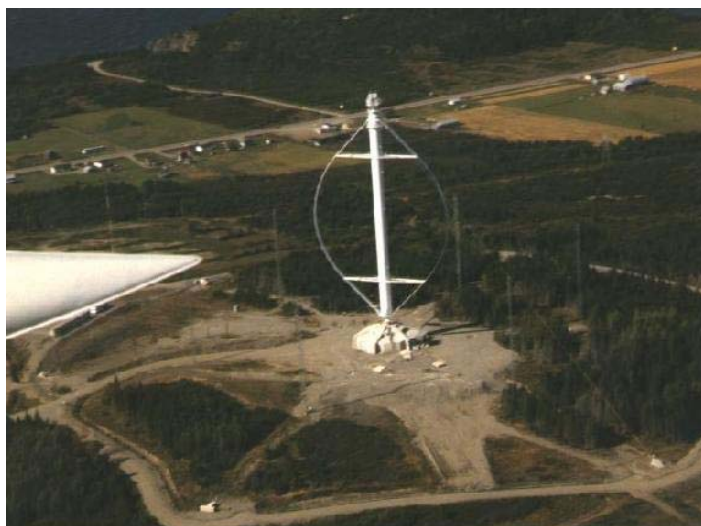
Figura 3.11. Aerogerador Eole C. Tipo Darrieus, 4,2 MW, diâmetro 64m, altura 96m, corda 2,4m, diâmetro da torre 5m. Velocidade de partida 4,5m/s, corte 22,5 m/s.
