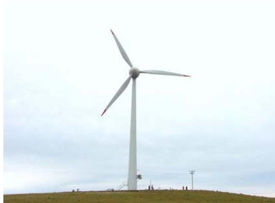
Figura 9. Aerogerador em Bom Jardim da Serra, 600 kW, diâmetro de 44 metros.
