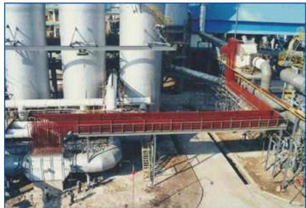
Figura 1.16. Trocadores de calor em circuitos (loop thermosyphons) empregados na indústria na China.
