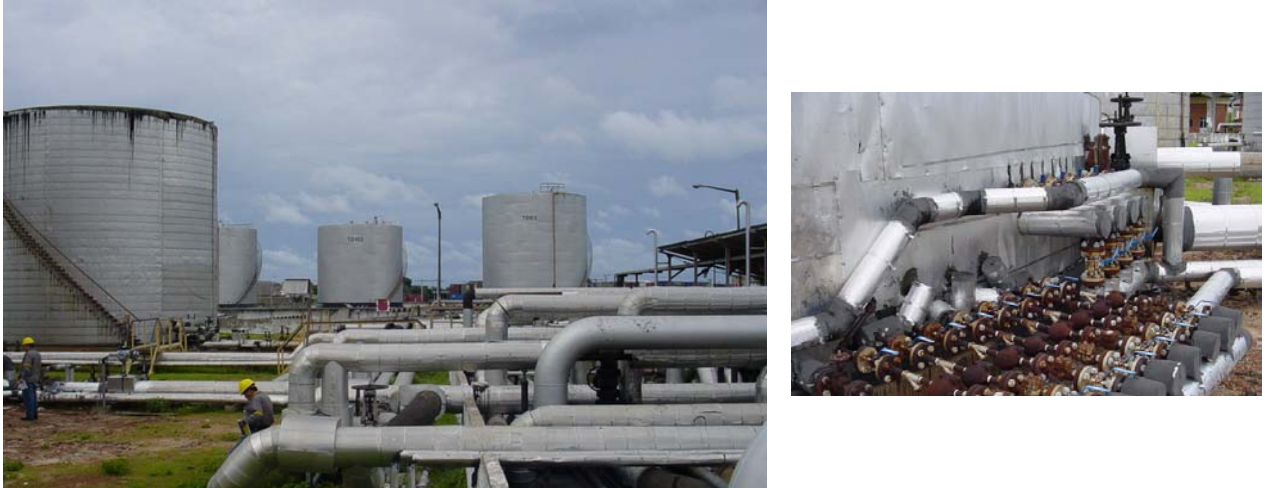
Figura 1: Tanques de armazenamento de CAP com detalhes de entrada e saída de vapor.
