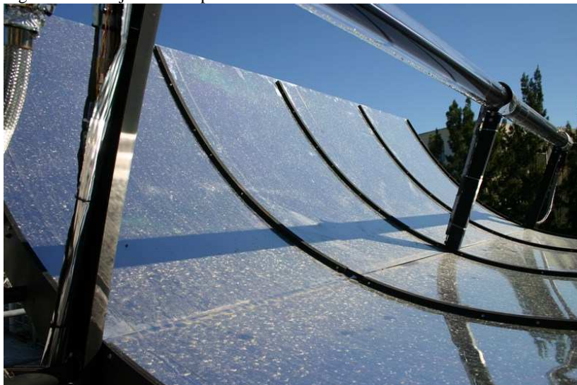
Figura 4.19 - Sujeira no tubo de vidro do elemento absorvedor
