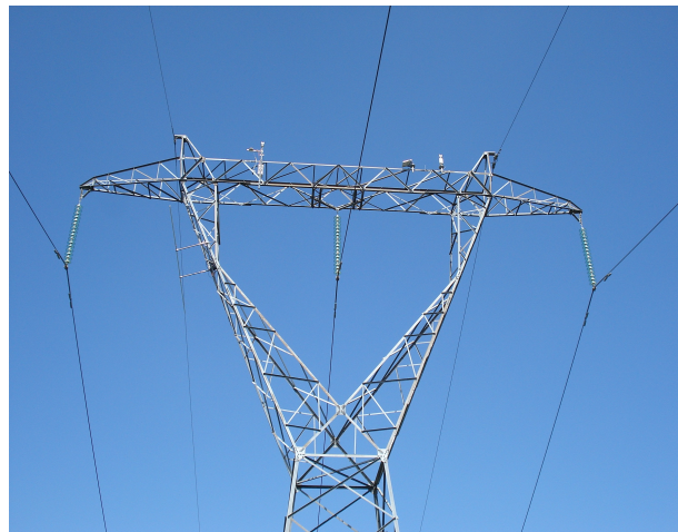
Figura 2: Foto da torre de 230kV de Santo Amaro da Imperatriz. Face Oeste.
