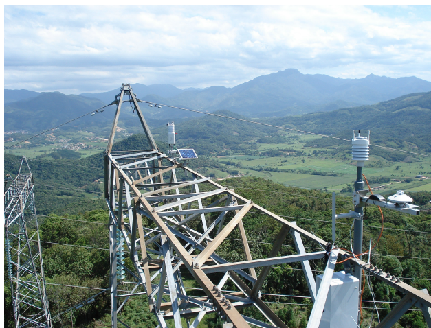
Figura 1: Foto das duas estações meteorológicas compactas no topo da torre
