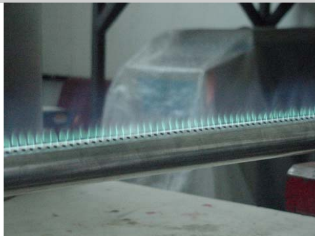
Fig. 5. Fotografia do queimador tipo flauta instalado no forno (Queimador Esquerdo)
